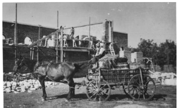
A római katolikus templom építése: Szabó Sándor lovas kocsijával a vizet hordja 1938-ban
