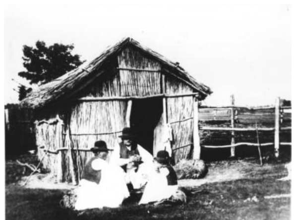
Cserény (a magyar népi építészetben nád- vagy vesszőfontatú pásztorenyhely) a jakabi pusztán 1906-ban
